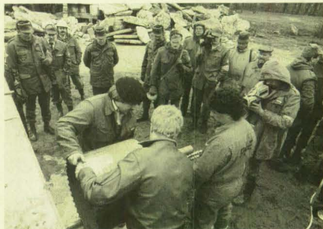
An einem dicken Stück Stahlbeton zeigten THW-Helfer und Vertreter der Herstellerfirma den Übungsbeobachtern die Funktion des Kernbohrgerätes.
