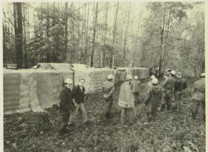
Die Pontons vor der Sprengung.
