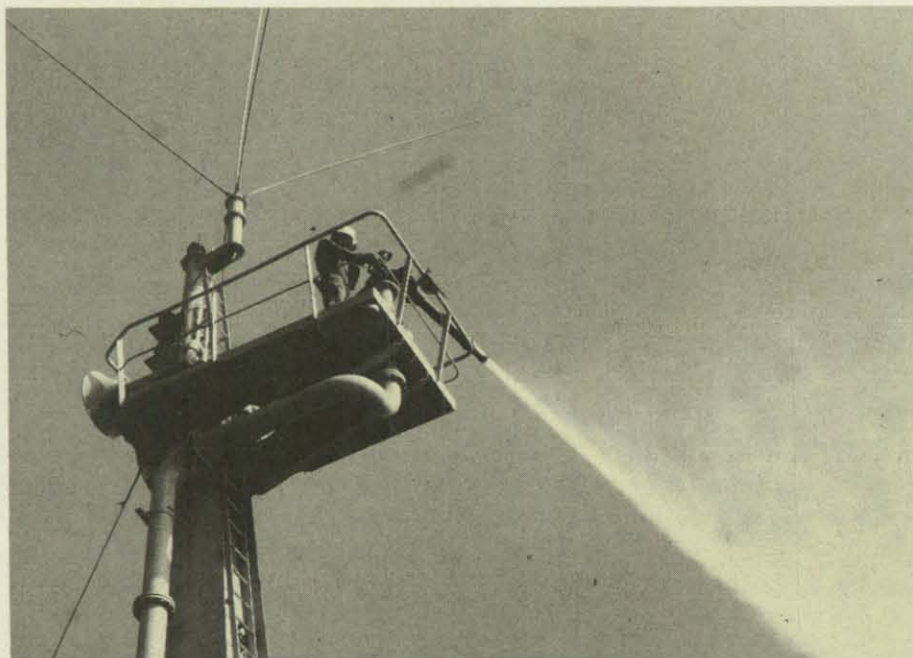
Mit der Löschkanone auf dem 15 Meter hohen Vormast läßt sich die Hälfte des Vorschiffes bestrahlen.
