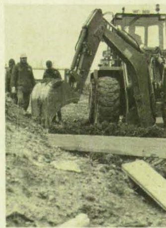
Helfer des THW-Ortsverbandes Wolfenbüttel auf ihrer Wochenend-Baustelle in der DDR. (Foto: Gralle)
