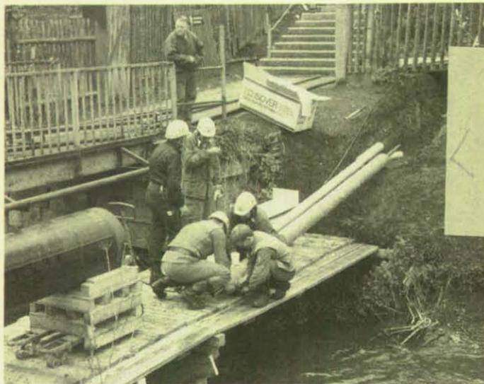
Beim Verlegen der Fernwärme-Leitung mußte auch ein Bach behelfsmäßig überbrückt werden. (Foto: Karsten)
