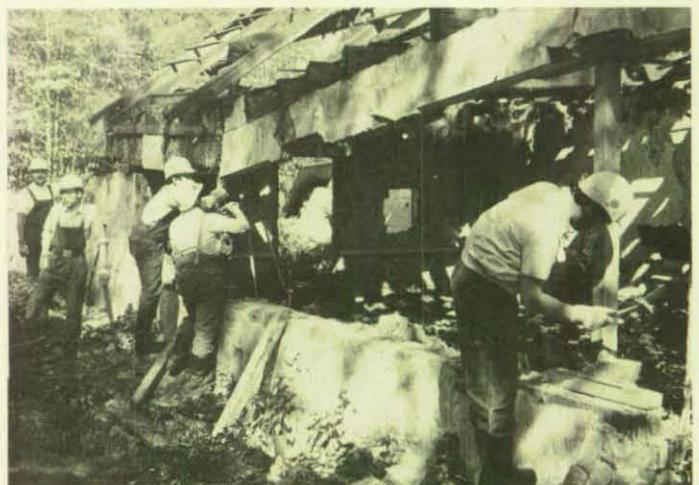
Helfer des 1. Bergungszuges Gronau stützen einsturzgefährdete Gebäude- teile ab. (Foto: Meyer)
