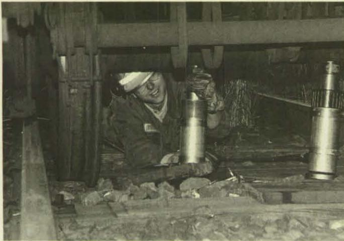
Aufgabe der Einheiten des THW ist es, die entgleisten Wagen mit Hilfe der Hydraulikheber wieder aufzulegen.
