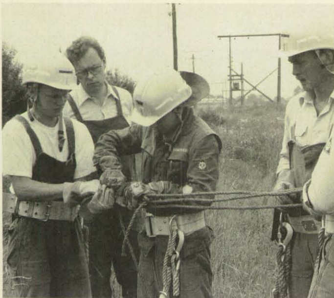
Kritisch beobachtet Ortsbeauftragter Pfeiffer (2. v. l.) die Vorbereitungen für den Freileitungsbau. (Foto: v. Geffert)
