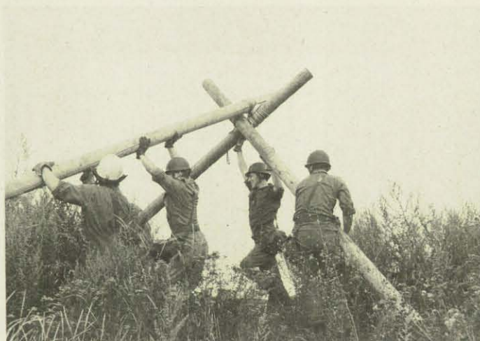
Ein Dreibock wird aufgerichtet.
