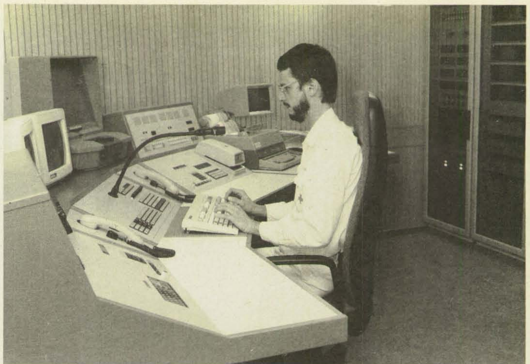
Der Sondereinsatz-Leitplatz mit Telex und Telefaxgerät, im Hintergrund Langzeitdokumentationsanlage und Steuerelektronik für Funk und Telefon.
