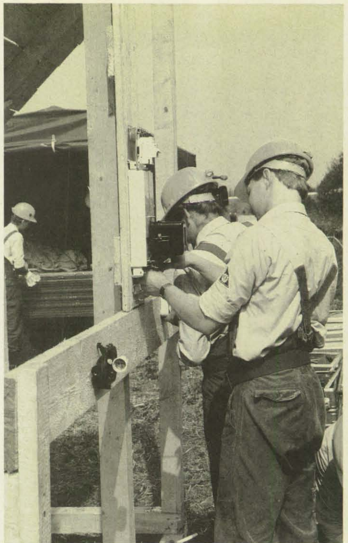
Auch das Erstellen einer Hausversorgung wurde im Wettkampf verlangt. (Fotos: Bormann)
