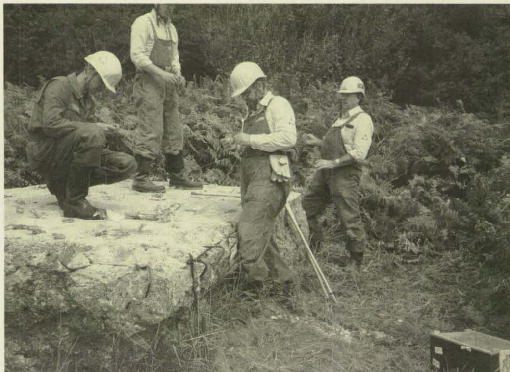
Das Anbringen der Sprengladungen erfordert sorgfältige Arbeit.
