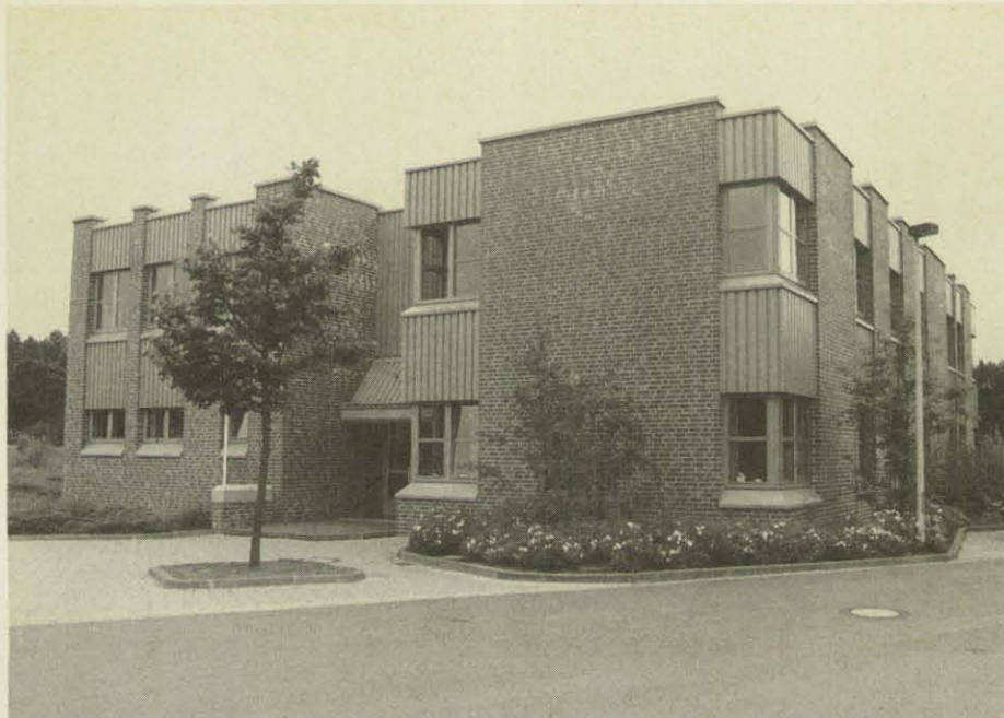
Im Erdgeschoß dieses Gebäudes auf dem Übungsgelände der Landesfeuerwehrschule NRW ist die Prüfstelle untergebracht.
