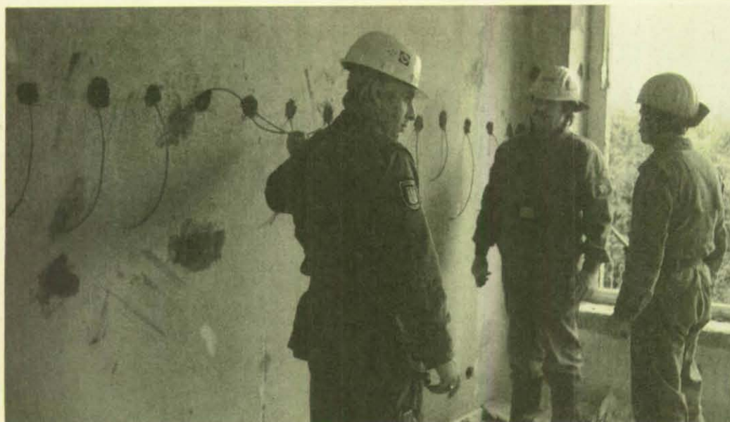
Sprengmeister Engel (links) überwacht das Besetzen der Bohrlöcher.
