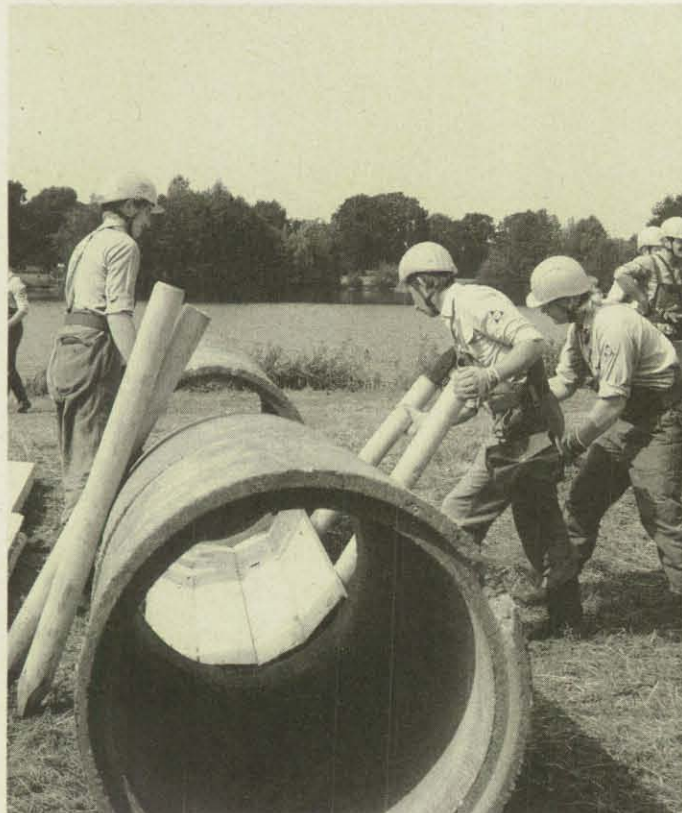
Die provisorische Instandsetzung einer Abwasserleitung als Wettkampfaufgabe.
