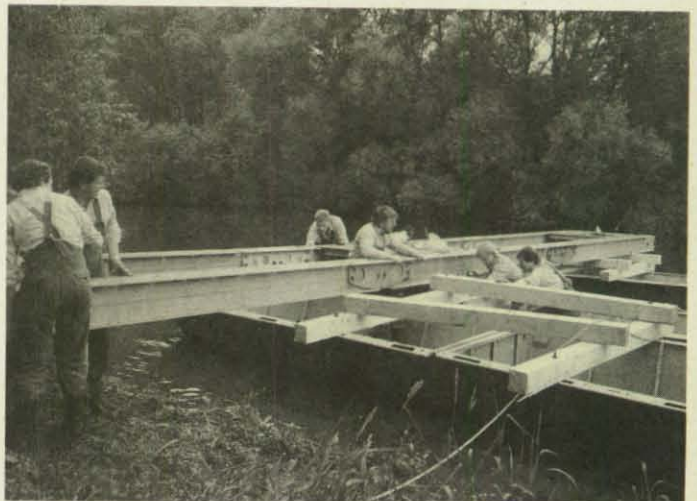
Kein leichtes Stück Arbeit: Der Bau der Brücke über die Fulda.
