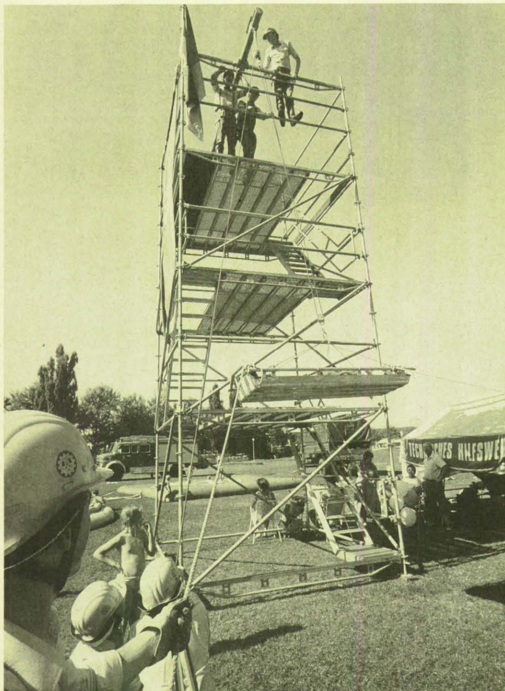
Der acht Meter hohe Gerüstturm lockt viele Besucher zum Stand des THW.
