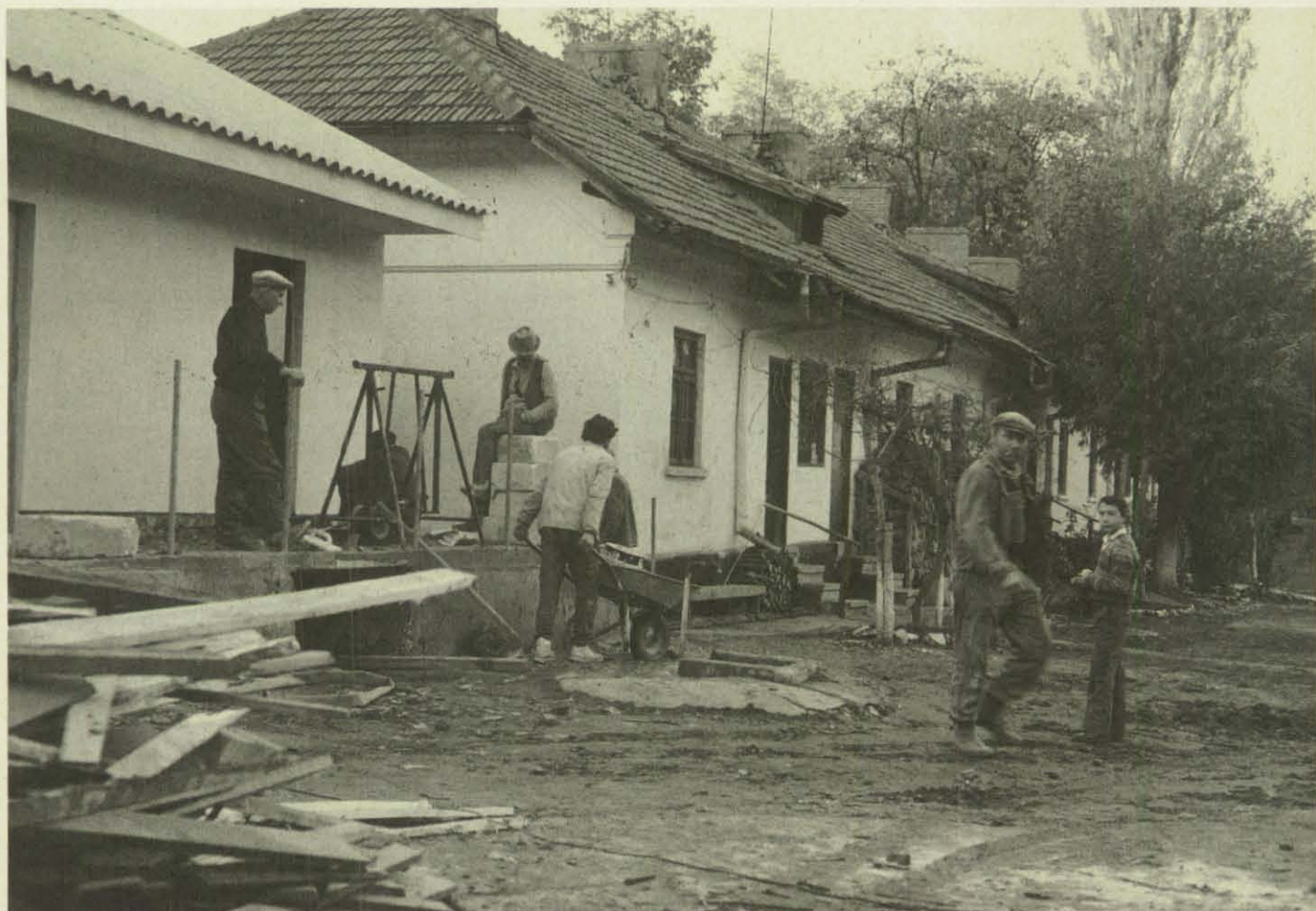
Die Baumaßnahmen im Lepradorf Tichilesti schreiten gut voran.
