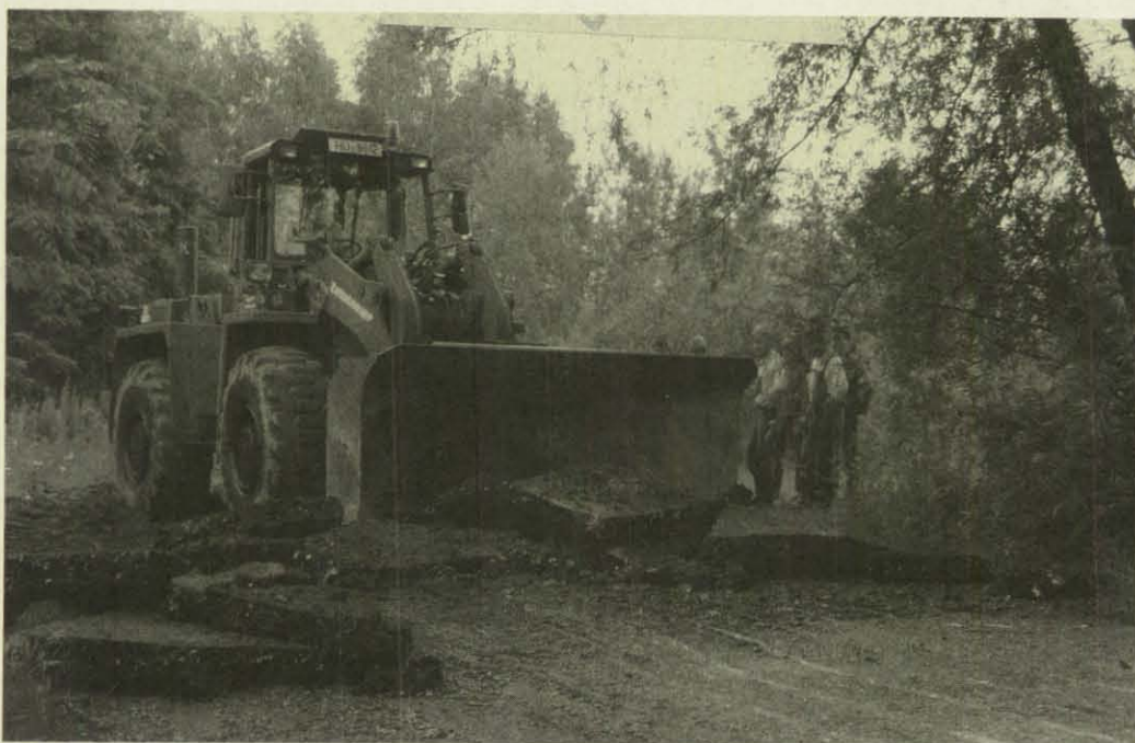
Mit dem Bergungsräumgerät ist die Asphaltdecke schnell aufgebrochen.
