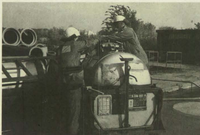
Fachmännisch wird ein Behälter mit „Schadstoffen“ abgedichtet. (Foto: Krüger)
