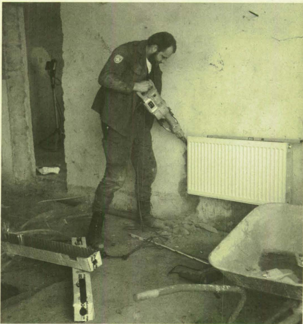
Auch die Heizungsanlage wird von den Malteser-Helfern installiert.
