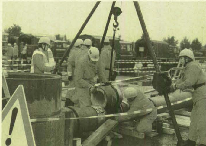
Das Einpassen des Betonrohres in den Abwasserkanal erfordert fachliches Geschick. (Foto: Rupprecht)
