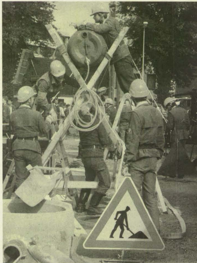
Das Aufstellen eines Wasserhochbehälters gehört zu den Anforderungen des Landeswettkampfes. (Foto: Gülzow)
