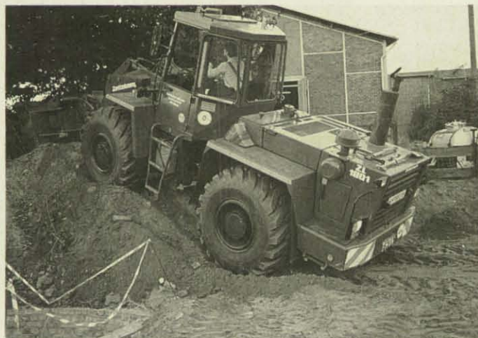
Bei den Erdarbeiten bewährt sich der Radlader der Bergungsräumgruppe.
