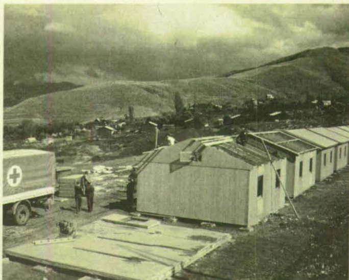
Aufbau von vorgefertigten Holzhäusern durch das DRK.
