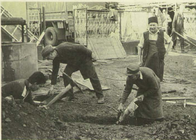
Das Anlegen der Verbindungsgräben ist bei dem tiefgefrorenen Boden ein hartes Stück Arbeit.
