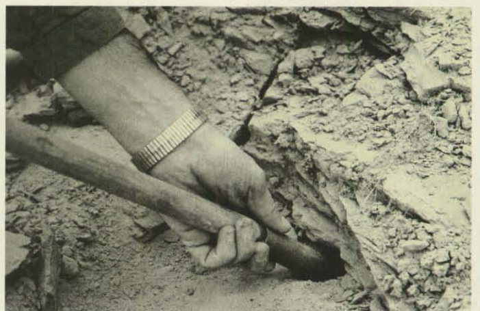
Mit Hilfe eines Ladestocks wird eine Sprengpatrone in ein Bohrloch eingeführt.
