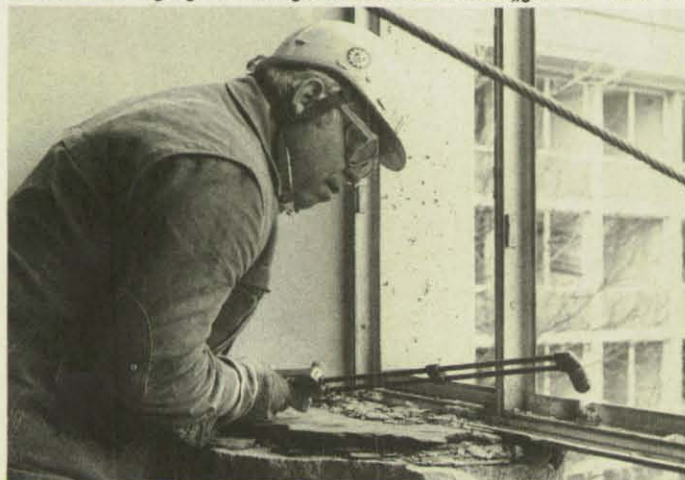
Ein THW-Helfer durchtrennt die Querstrebe des Metallfensters.
