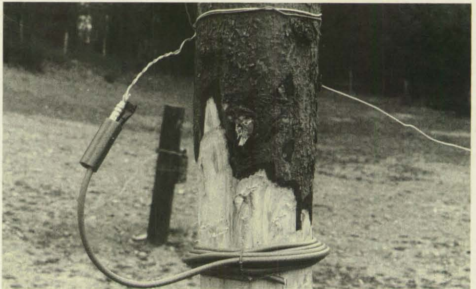
Rundhölzer können auch mit Hilfe einer Sprengschnur durchtrennt werden.
