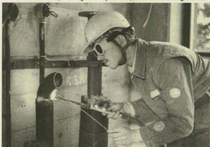
Zum Einsatz kommen auch Helfer des THW-Instandsetzungszuges.
