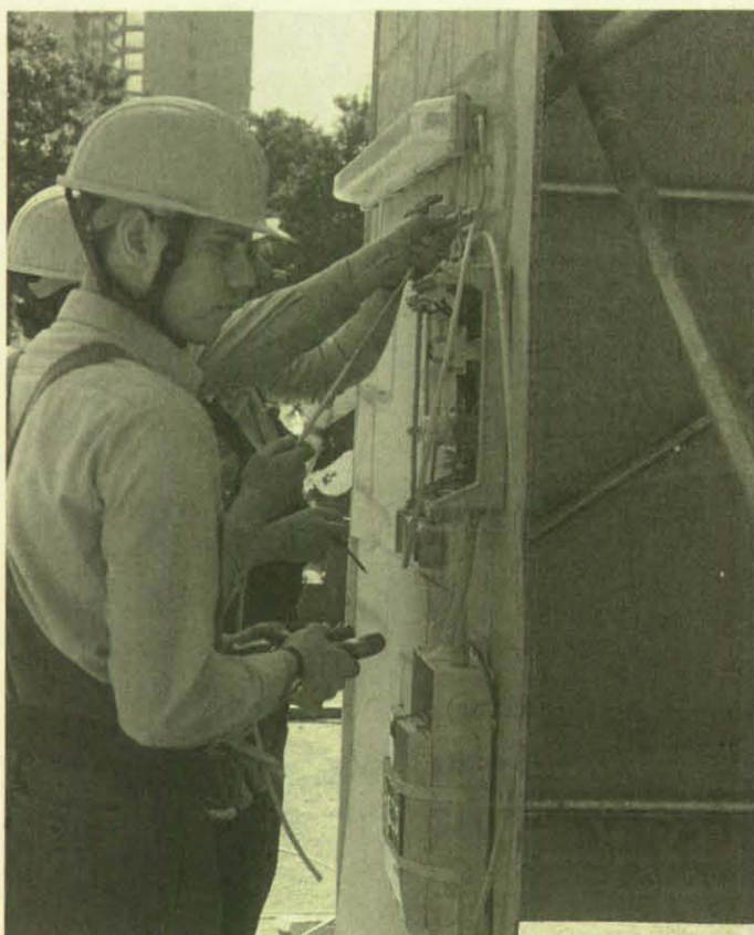
Helfer der Elektro-Gruppe installieren einen Elektro-Hausanschlußkasten.
