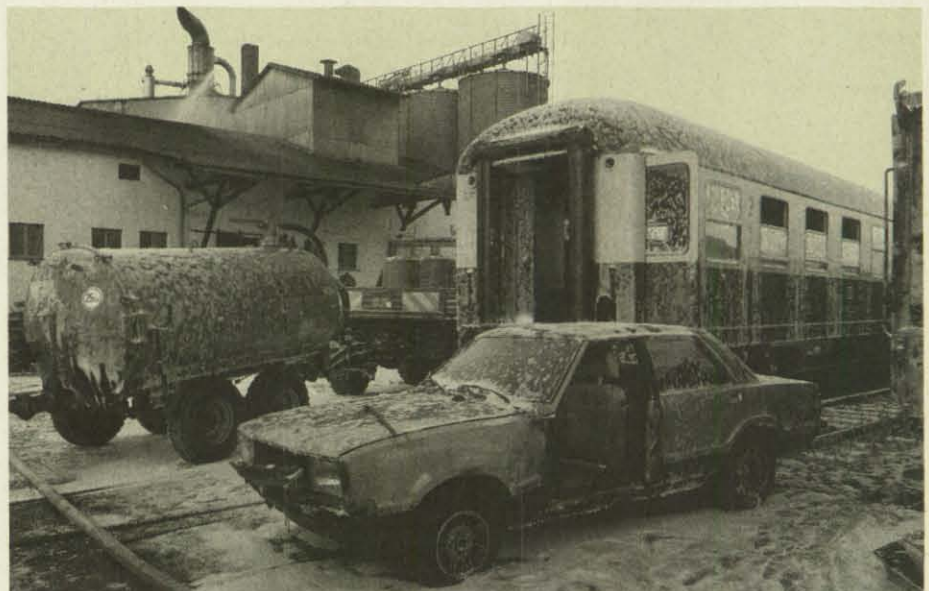
Die Schadensstelle in Groß-Bieberau.
