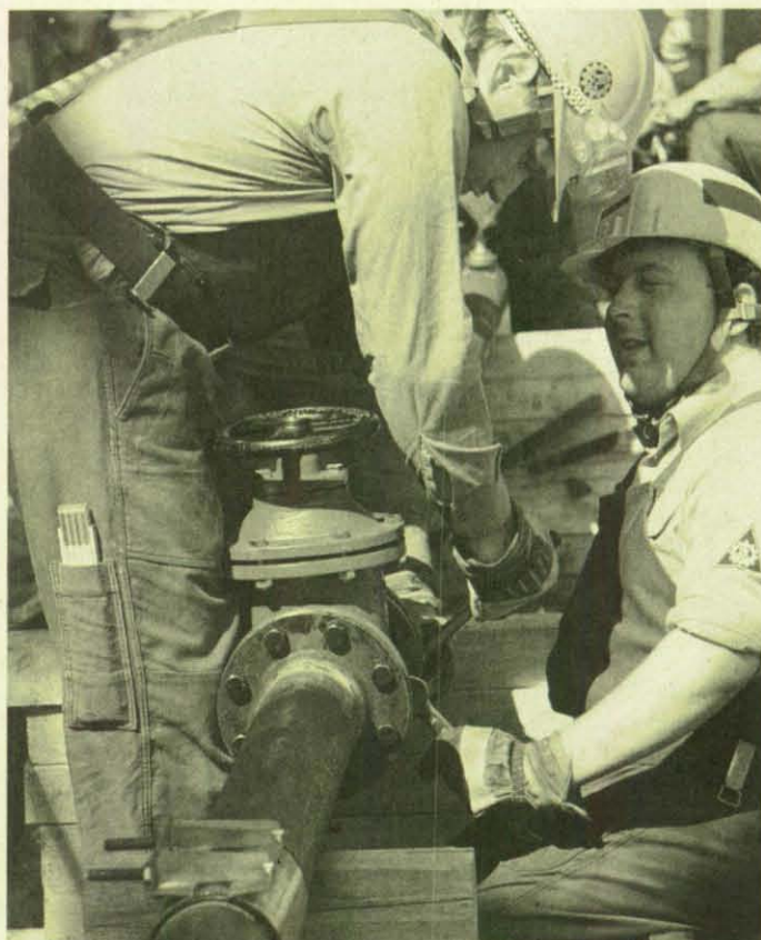
Aufgabe der Gas-/Wasser-Gruppe ist der Einbau eines Schiebers.
