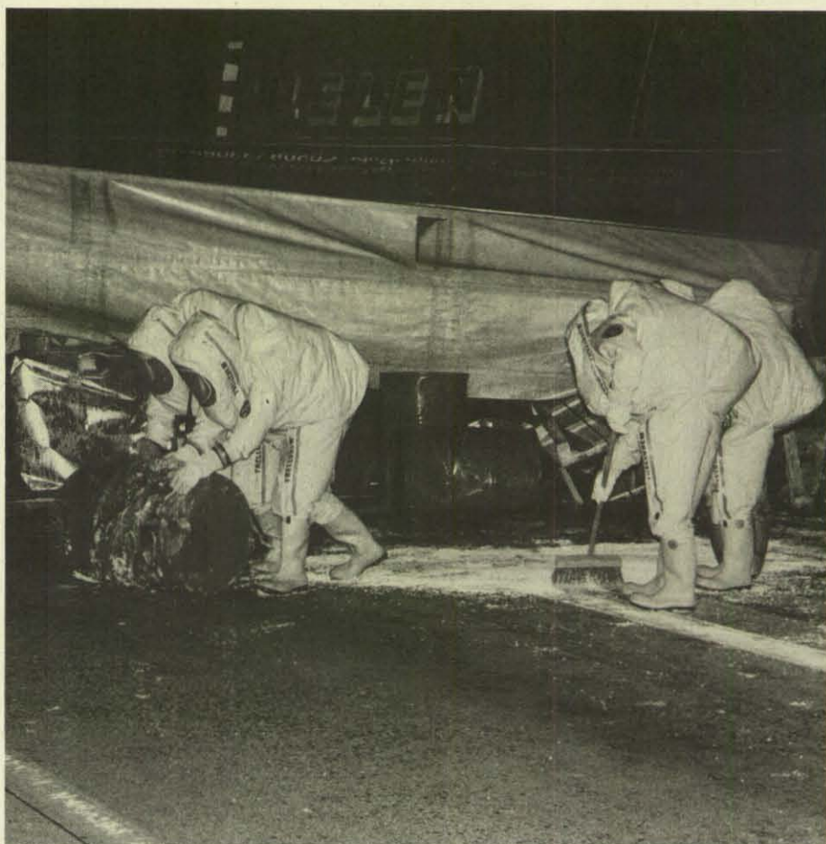
Ausgelaufene Substanzen werden durch Bindemittel aufgenommen – unbeschädigte Fässer zum Abtransport verladen.
