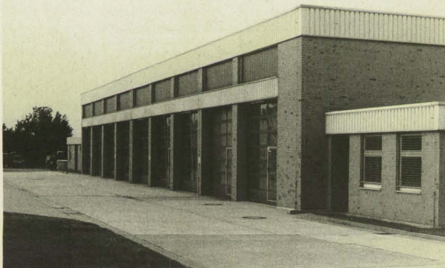
Der großzügige technische Bereich in Bad Nenndorf.
