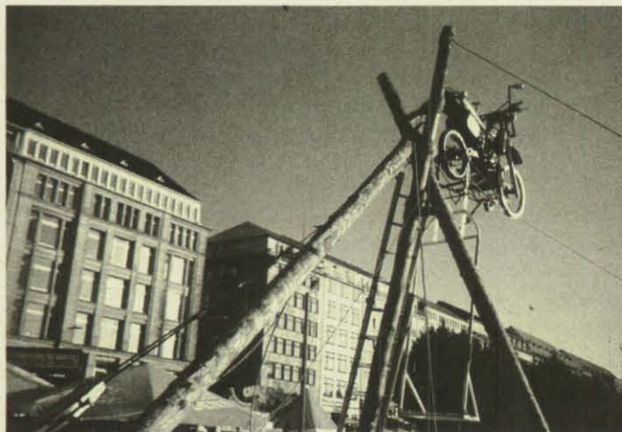
Am Dreibock wird das 525 Meter lange Stahlseil über die Binnenalster gespannt.
