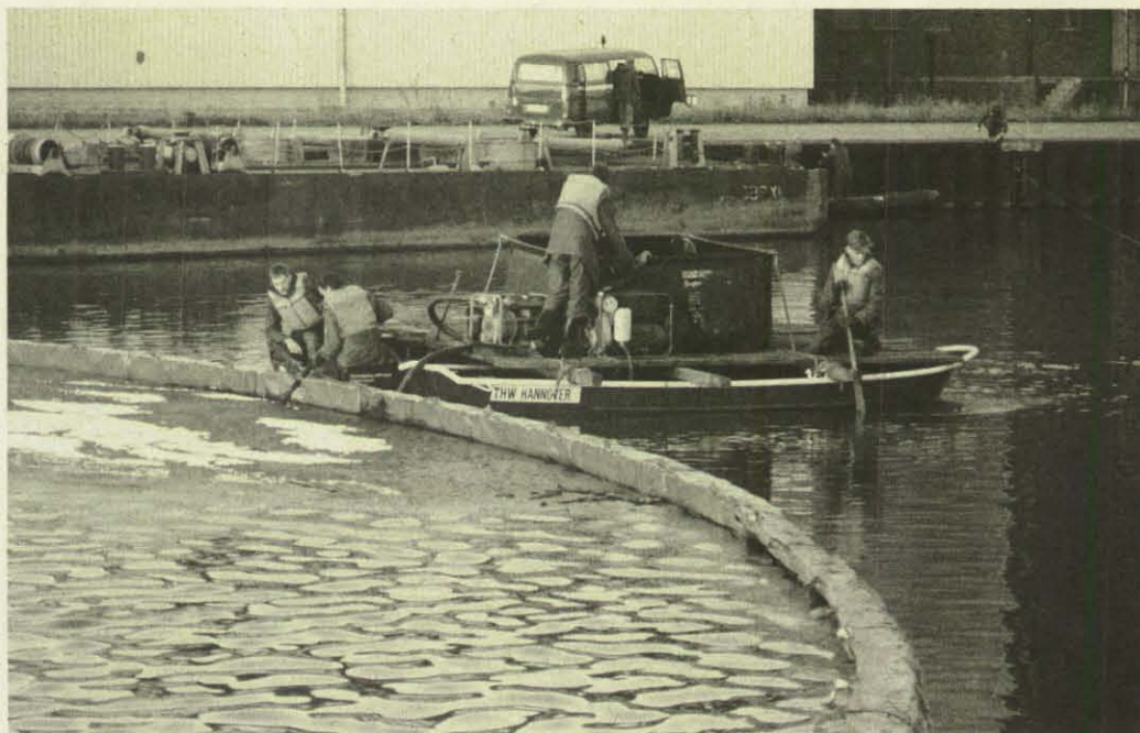
Mit der Öl-Saugpumpe wird das Öl/Wassergemisch in den Sammelbehälter auf den THW-Stahlbooten umgefüllt. (Foto: Graser)
