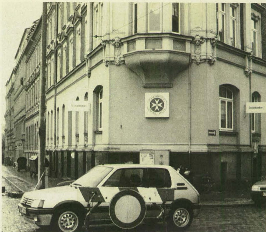
Das renovierte Gebäude in der Haydnstraße in Plauen, in dem die Sozialstation in zwei Wohnungen untergebracht ist.
