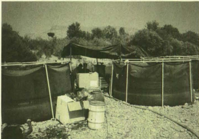
Um ein wenig Schatten zu haben, wird bei den Rohwasserbehältern der Anlage eine Zeltplane gespannt. (Fotos: Kardel)
