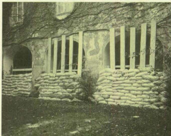
Mit einfachen Mitteln werden Gebäude geschützt, hier Sandsäcke vor dem Nationalmuseum in Zagreb.
