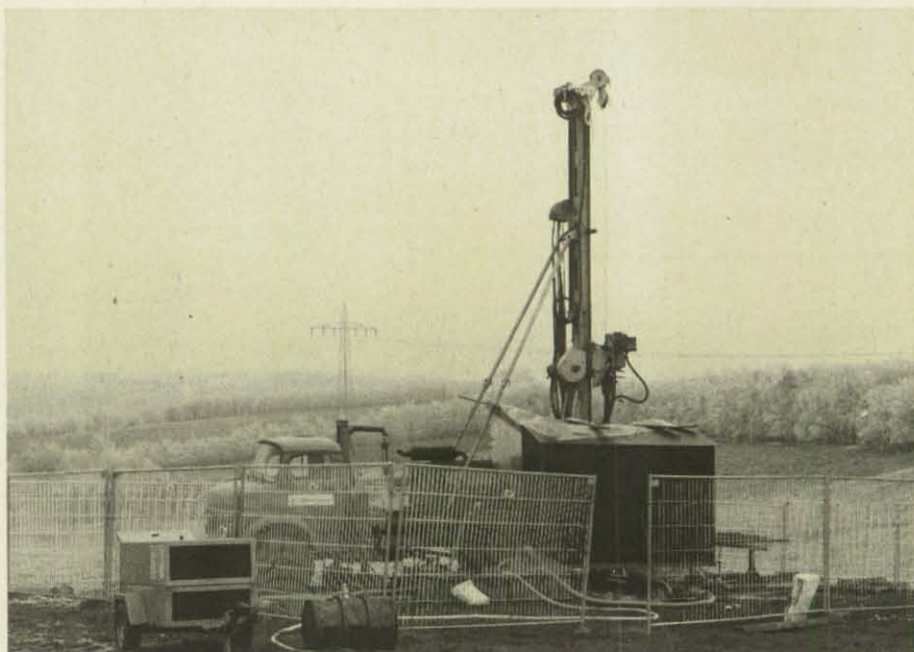
Zur ständigen Beobachtung des Grundwassers werden Brunnen niedergebracht.
