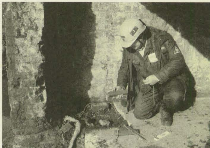
Fertigen der Ladung.
