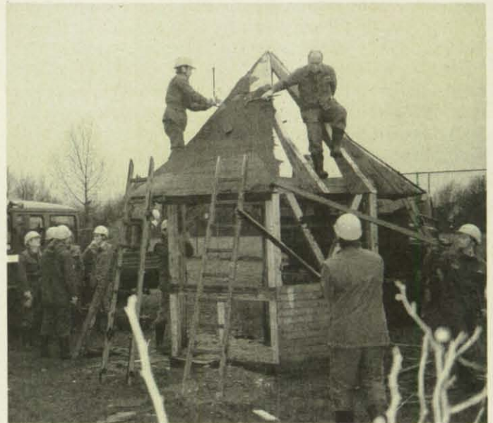
Der Abbau der Ruhelaube bereitet den THW-Helfern keine Probleme.
