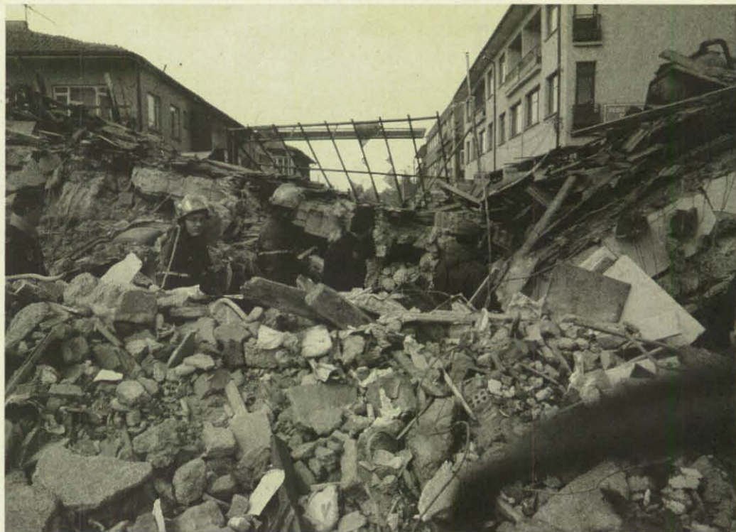
Die Helfer müssen sich durch meterhohe Trümmer vorarbeiten.
