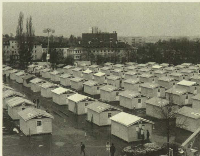
Ein Blick auf das „Schnellbauhäuser-Dorf“ verdeutlicht das Hilfspotential, das durch die Bau-Lehrlinge geschaffen wurde.
