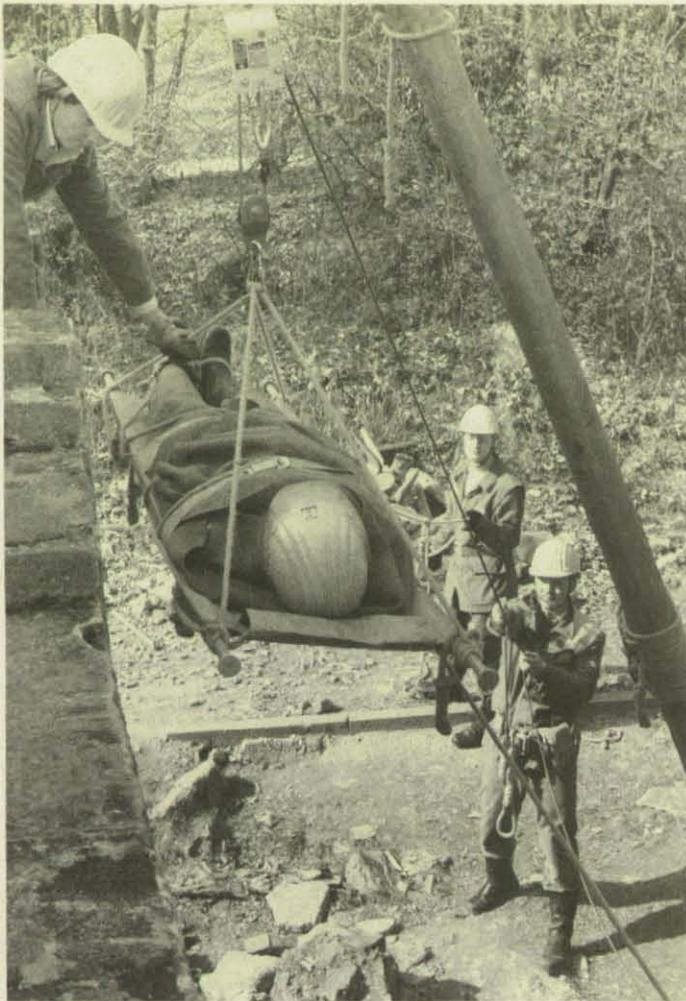
Mit Hilfe des Rollgliss-Geräts wird ein „Verletzter“ auf einer Trage abgelassen.
