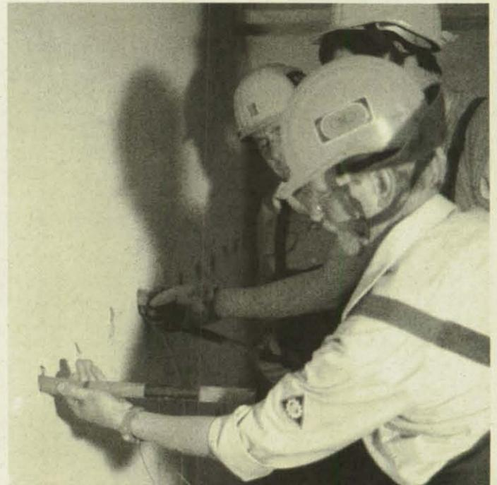
Bei den Vorbereitungen zur Sprengung ist äußerste Sorgfalt gefordert. (Foto: Kardel)
