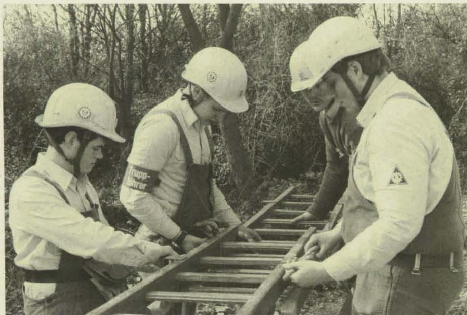
Mit Hilfe von Steckleiterteilen baut der Trupp einen Steg.
