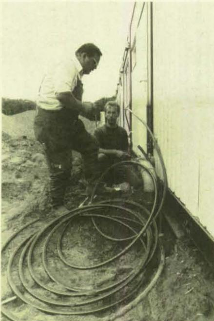
Die einzelnen Wohneinheiten werden an die Wasserversorgung angeschlossen.
