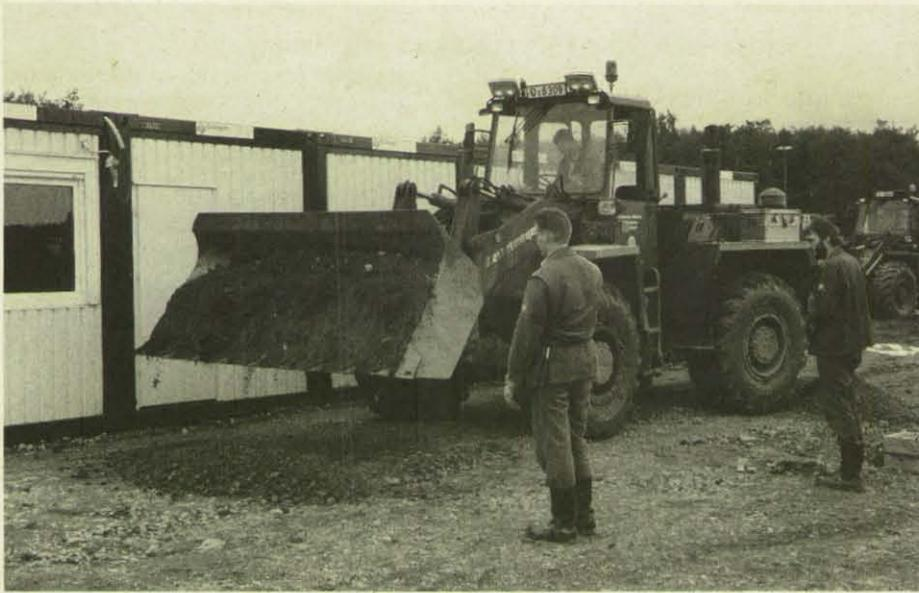
Zur Befestigung des Geländes wird Schotter aufgebracht.
