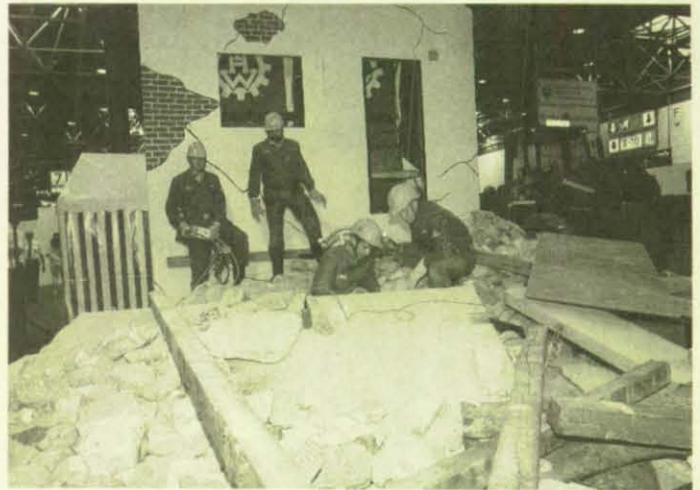
THW-Helfer demonstrieren auf einem Trümmerkegel unterschiedliche Bergungsmethoden.
