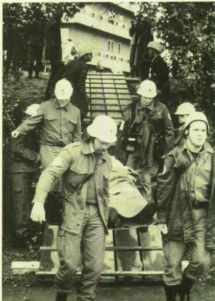
Mit der Errichtung einer Rampe ermöglicht das THW den sicheren Abtransport der „Verletzten“.
