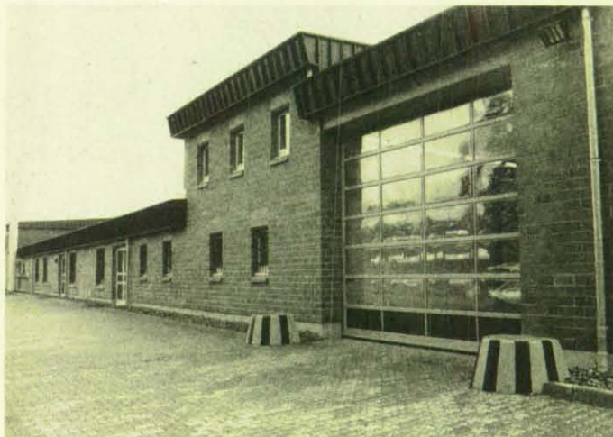
Die Rückfront des Gebäudes.
