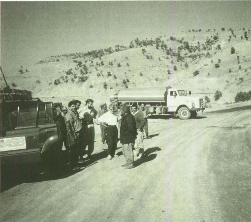
Die einzige Transitverbindung durch die kurdische Schutzzone wird mit einer selbstbindenden Schotterdecke winterfest gemacht. Die nordrhein-westfälische Landesregierung unterstützt dieses Projekt des ASB.
