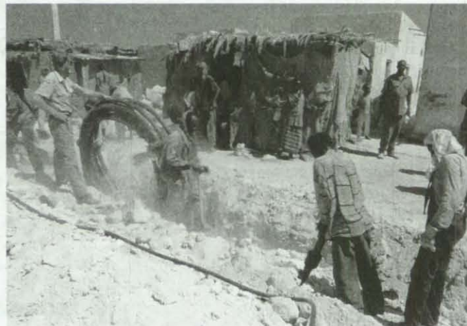
Mit einheimischer Hilfe wird die Ringleitung zur Wasserversorgung verlegt.
