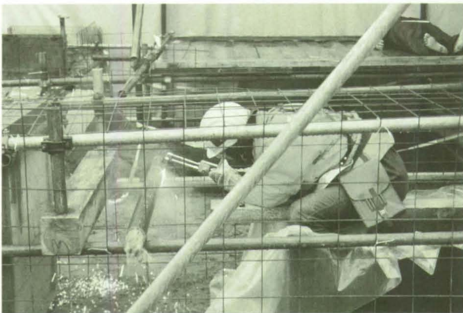
Dieses Rohr mußte mittels Brennschneidergerät durchtrennt werden.
