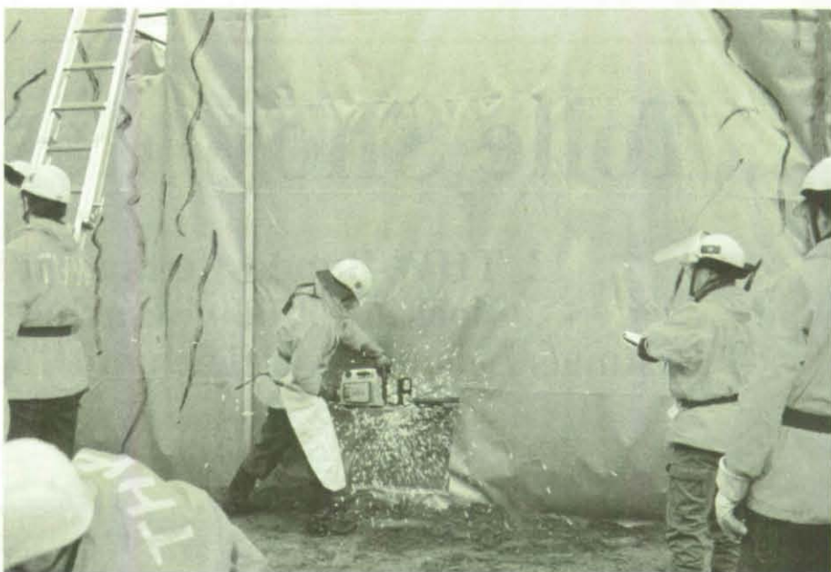
Ein „Kellerfenster“ wird mittels Trennschleifer durchtrennt.
