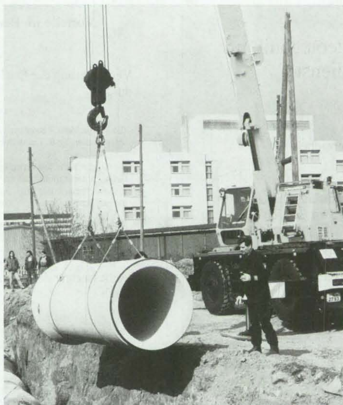
Bei der Verlegung der Abwasserleitung arbeiten Feuerwehr und THW Hand in Hand. (Foto: Dube)
