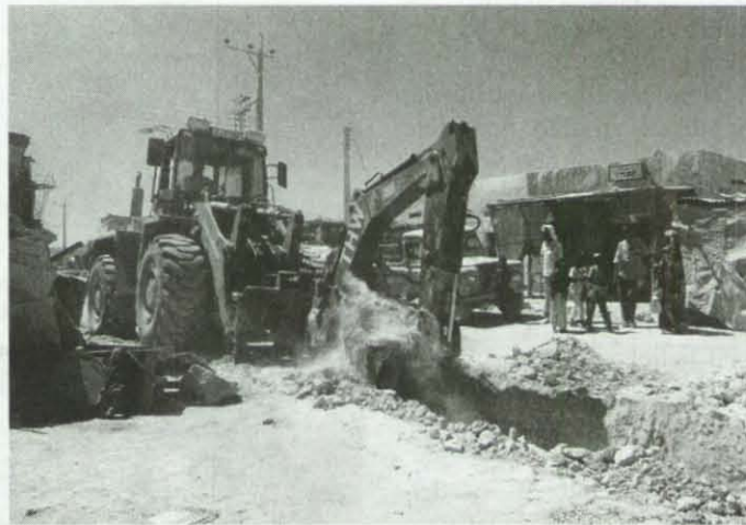
Bei den hohen Temperaturen ist die Unterstützung der Arbeiten durch das Bergungsgerät von unschätzbarem Wert.
