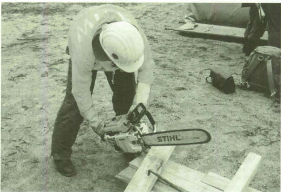
Einsatz der Motorsäge zur Vorbereitung der Aussteifungsarbeiten.
