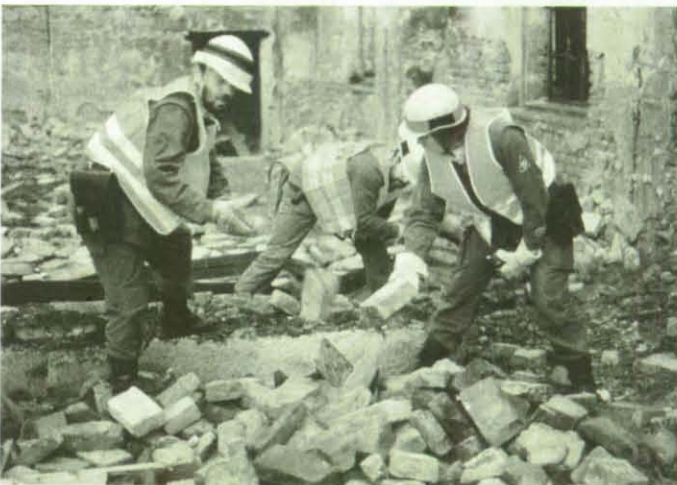
Per Hand werden Ziegelsteine weggeräumt, um einen Einstieg zu finden.
