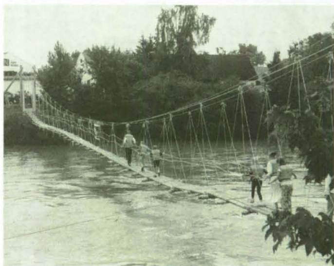
80 Meter auf schwankendem Boden über die Donau: Der Hängesteg des THW kann sich sehen lassen.
