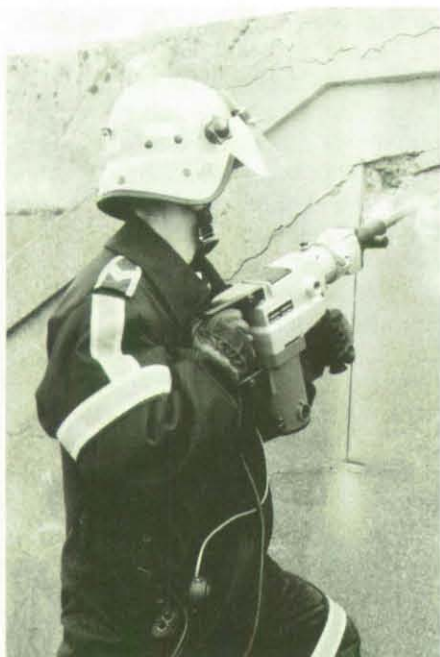
Ein polnischer Helfer beim Mauerdurchbruch.
