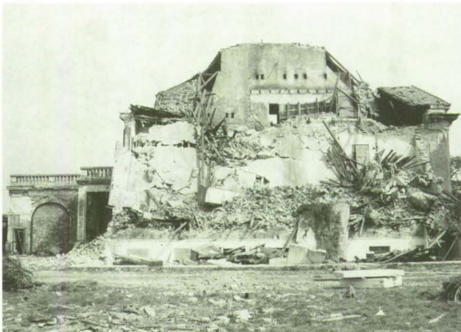
Eine der hervorragend präparierten Schadensstellen im Übungsgelände.
