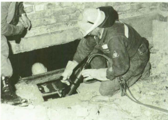
Die hydraulische Rettungsschere im Einsatz.
