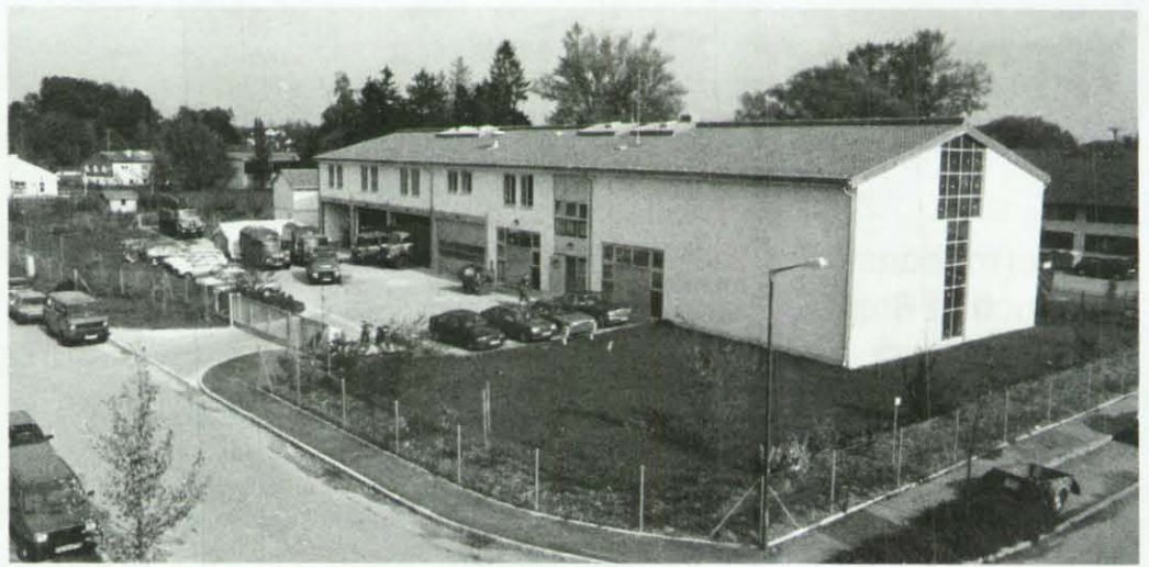
Eine runde Sache. Die neue Unterkunft des THW-Ortsverbandes Dachau.
