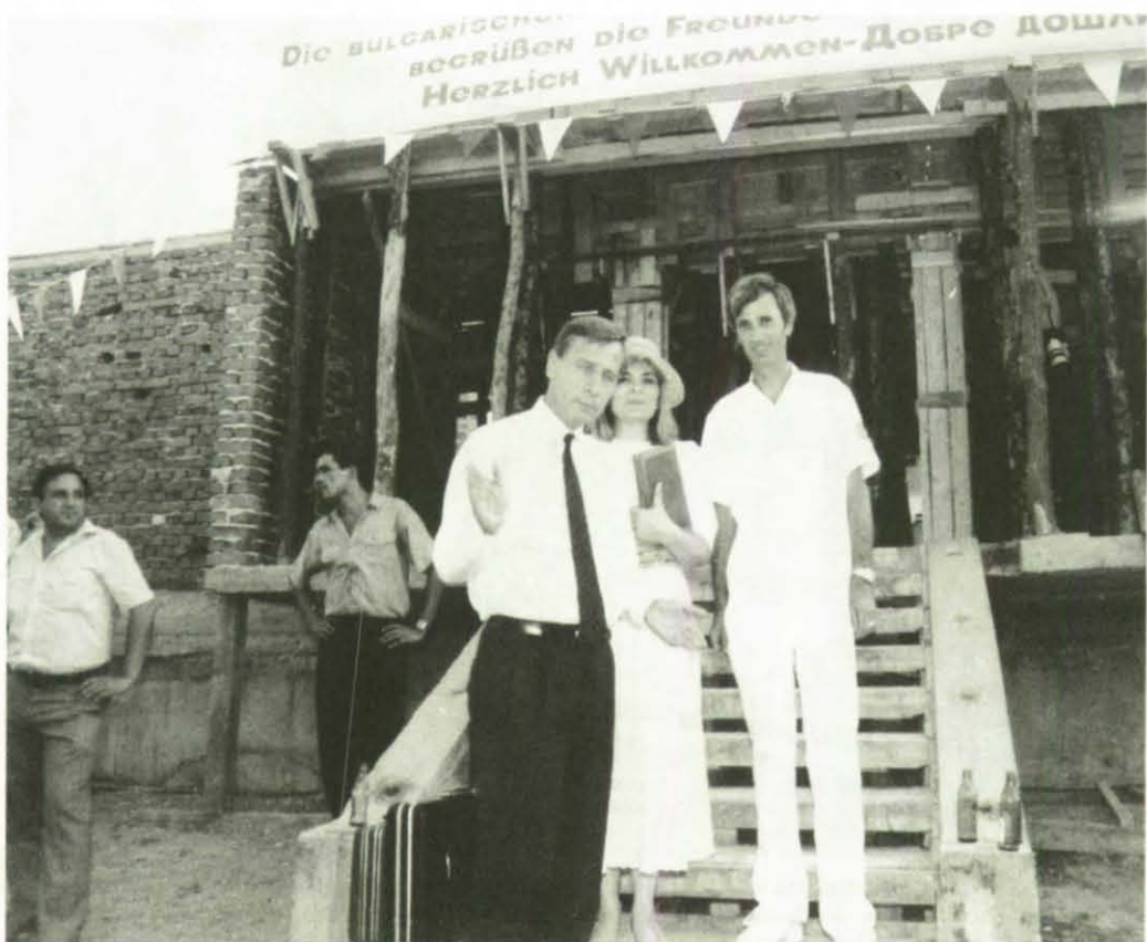
Wolfgang Clement, Chef der Staatskanzlei von NRW, besichtigt mit Alfred Ecke vom ASB den Rohbau der Rettungswache im bulgarischen Russe. (Foto: Boes)
