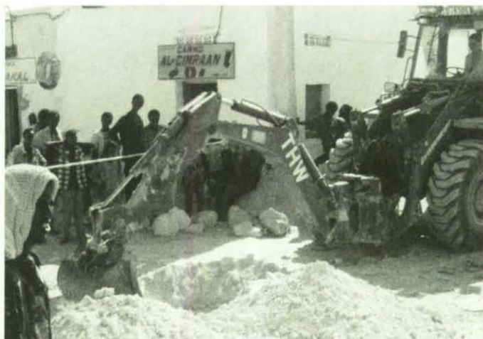
Somalia: Bauarbeiten für die Verlegung einer Wasserleitung. (Foto: Lohmann)
