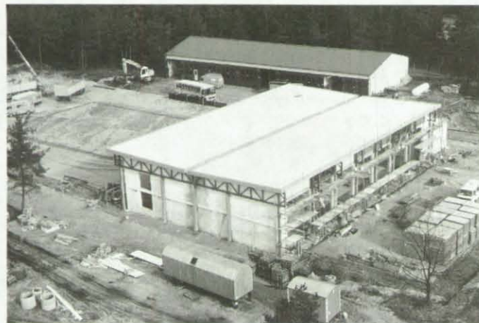
Im Bau ist die neue Fahrzeughalle.
