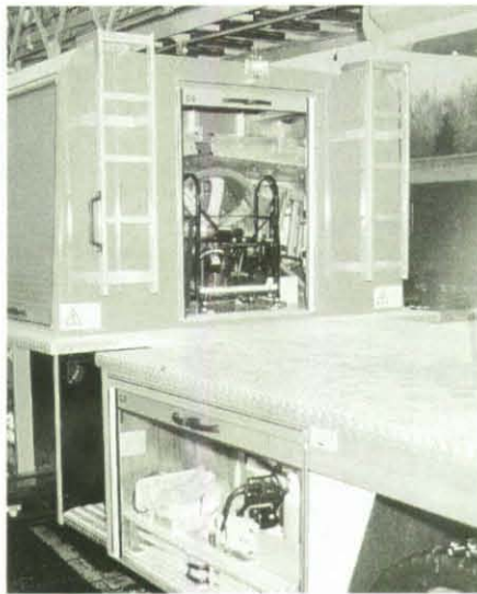
Hier wurde ein wettergeschützter Stauplatz für den Hochleistungslüfter geschaffen.
