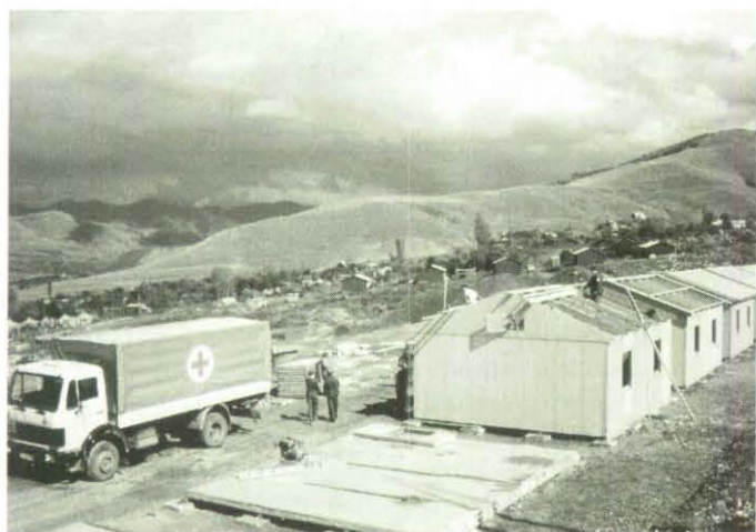
In Armenien errichtete das DRK Holzhäuser für die Opfer des Erdbebens. (Foto: Spiegl)
