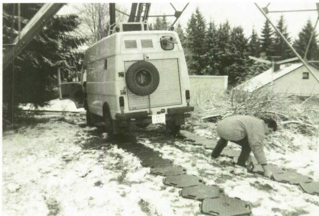
20 Platten ergeben eine 5,5 m lange Fahrspur.
