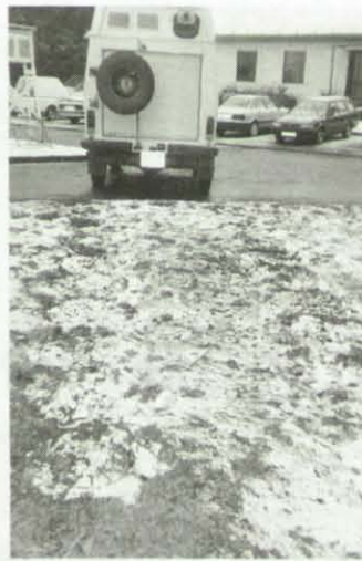
Die gitterartigen Plattenabdrücke im Untergrund sind vertretbar.
