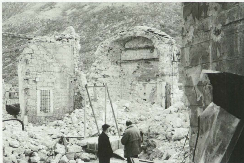
Viele Häuser in Mostar sind völlig zerstört. Sie bieten den Menschen oft nur notdürftig Unterkunft. (Fotos: ASB/Meyer)
