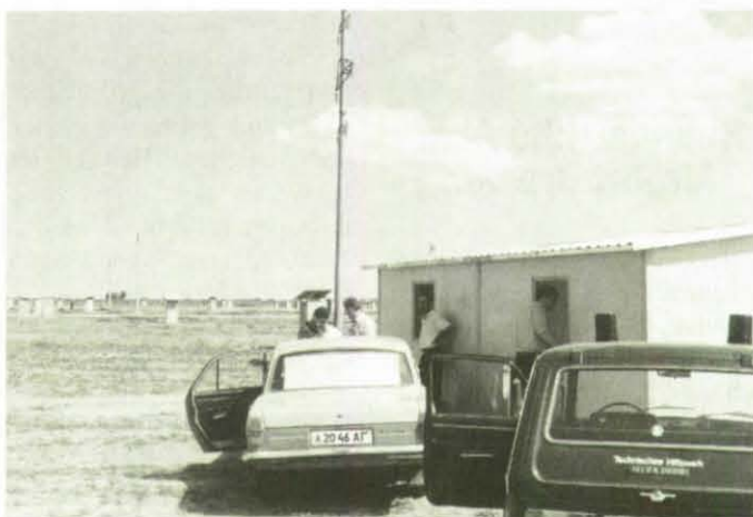
Baubesprechung im Schatten eines soeben erstellten Fertighauses im Flüchtlingsdorf Saatli. (Fotos: Bormann)
