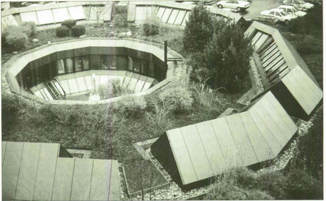
Das Telekommunikationszentrum (TELKO) des Auswärtigen Amtes verfügt über ein weltweites Netz gesicherter Verbindungen.
