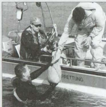
Auch unter Wasser müssen Sandsäcke verlegt werden.
