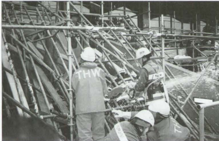
Unten: THW-Helfer beseitigen mit einem Trennschleifer eingestürzte Gerüstteile, um an „Verschüttete“ zu gelangen.
