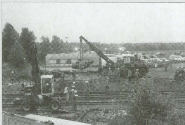
Nach teilweiser Streckenfreigabe unterstützt das THW die Bahn AG bei den Räumarbeiten.
