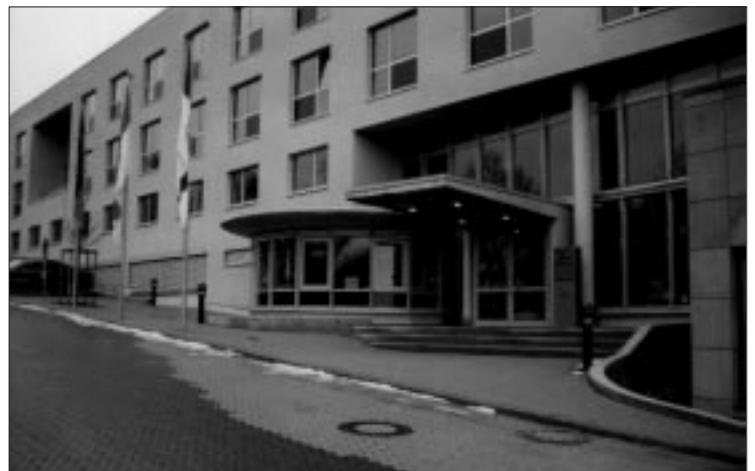
Nach der Erweiterung ist die Hessische Landesfeuerwehrschule für ihre Aufgaben bestens gerüstet. (Foto: Claes)
