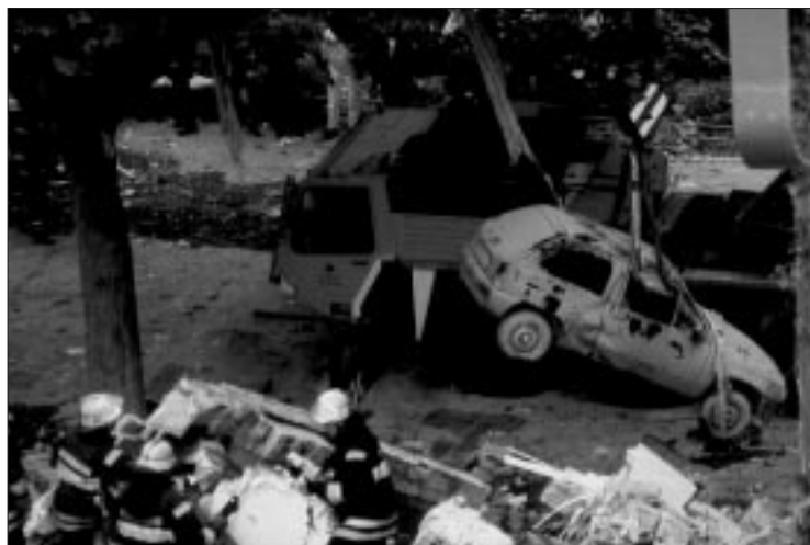
Auch schweres Gerät kommt zum Einsatz.
