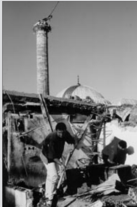
Wiederaufbau im Kosovo: Überall wird Schutt beiseite geräumt.
