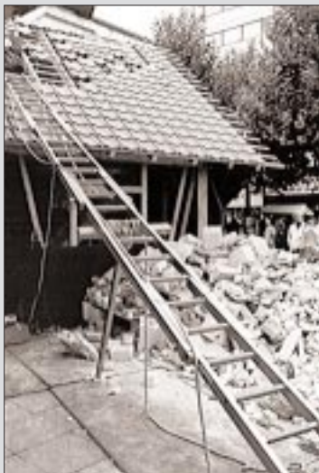
Das Fachwerkhaus mitten in der Fußgängerzone.
