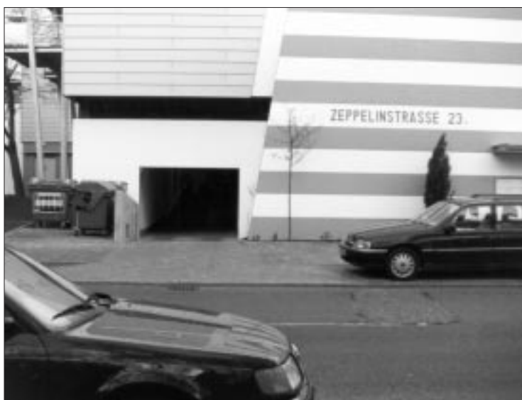
Garageneinfahrt in die Mehrzweckanlage, die in dem ehemaligen Hochbunker entstanden ist.
