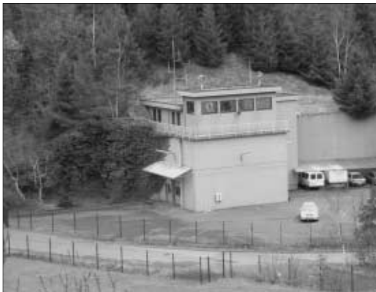
Eines der vier Eingangsbauwerke des Ausweichsitzes der Verfassungsorgane des Bundes. (Foto: Schmitter)
