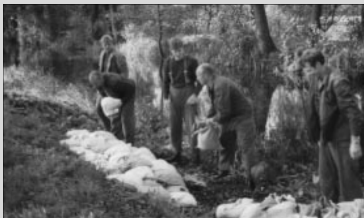
Auch das Befüllen und Stapeln der Sandsäcke will geübt werden.
