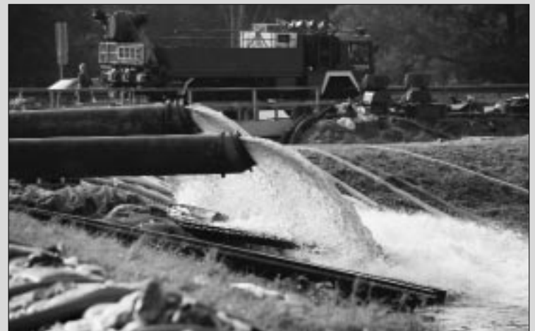
Die Pumpen hatten Schwerstarbeit zu leisten.
