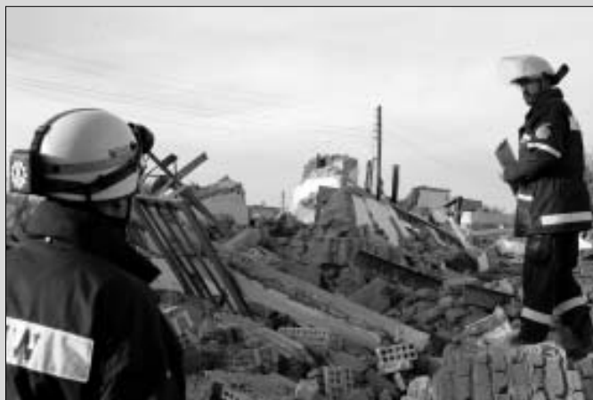
Die überwiegend aus Lehm erbauten Häuser hatten dem Beben nicht standhalten können und waren in sich zusammengefallen.
