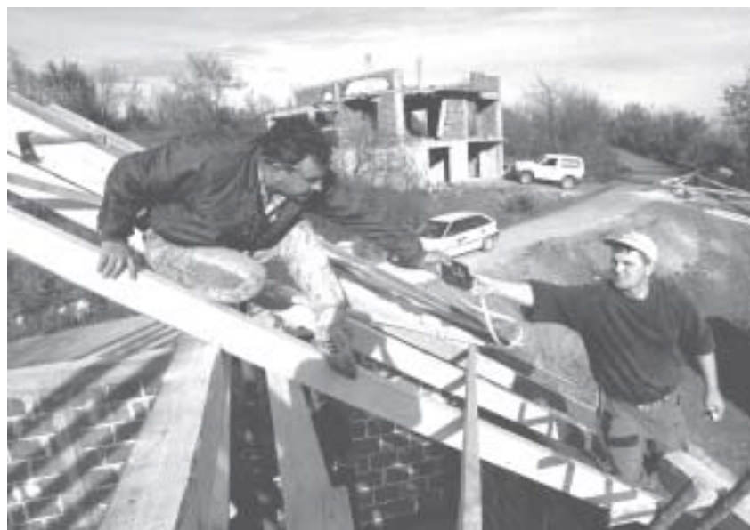
Bei den Wiederaufbauprojekten fördert der ASB die aktive Beteiligung der Begünstigten. Hier zwei Nachbarn in Bosanski Brod, die sich beim Wiederaufbau eines Wohnhauses helfen. (Foto: Wolfgang Gressmann, ASB)
