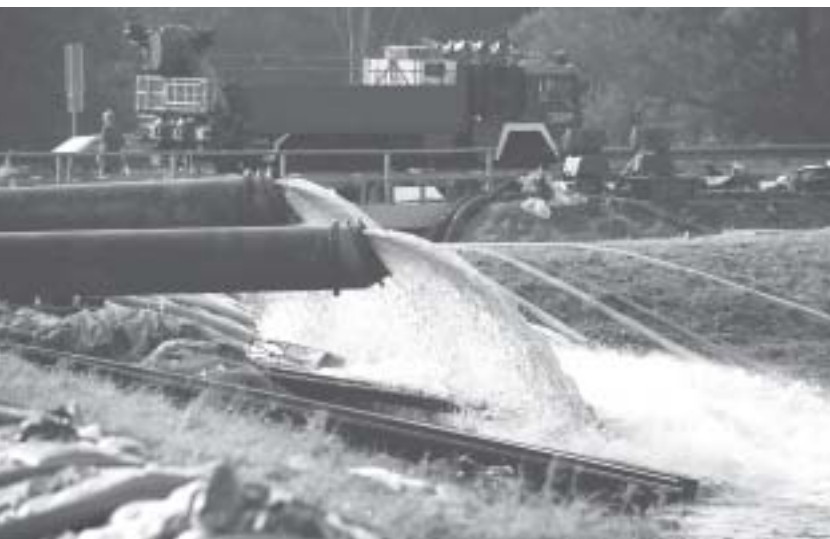
Die Fachgruppen Wasserschaden Pumpen des THW können europaweit zum Einsatz gebracht werden. (Foto: THW)
