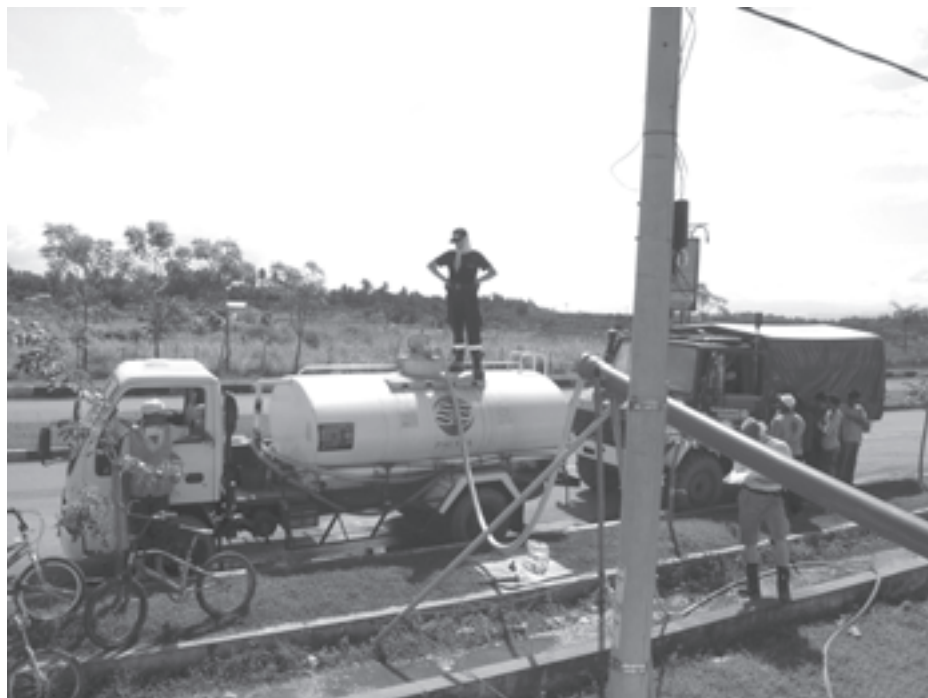
Nach der Aufbereitung wird das Wasser verteilt.
