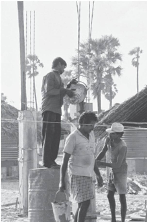
Mit einfachen Mitteln bauen lokale ASB-Mitarbeiter eine Schule in einem der Transitcamps.
