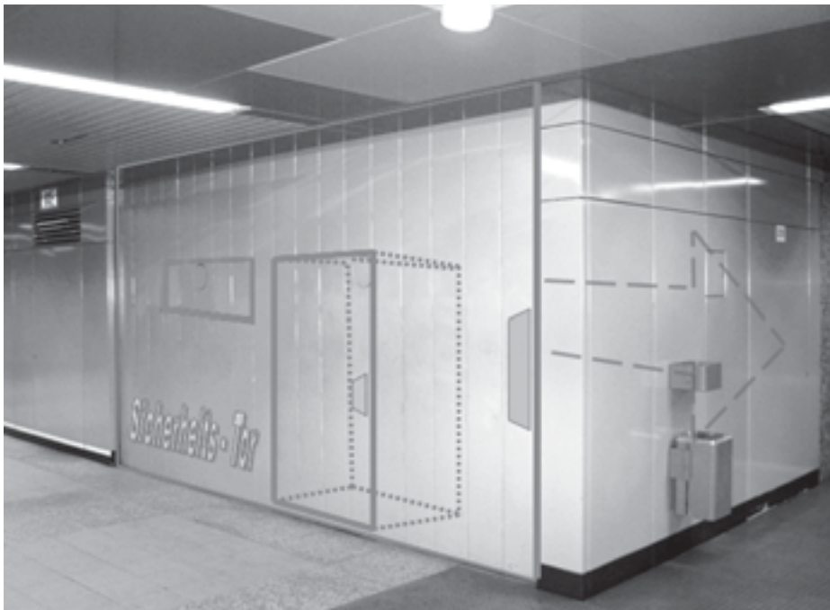
Anstelle des vorhandenen Schutzraums können schnell schließbare Stahltore mit Schlupftür und flexiblen Schleusen für eine sofortige Inbetriebnahme eines Sicherheitsbereichs sorgen. Mit (verplombten) Einhandverschlüssen können sie von jedermann im Gefahrfall ohne Spezialwerkzeug schnell geschlossen werden (siehe übergelegte Graphik). (Bild und Graphik: Turley)
