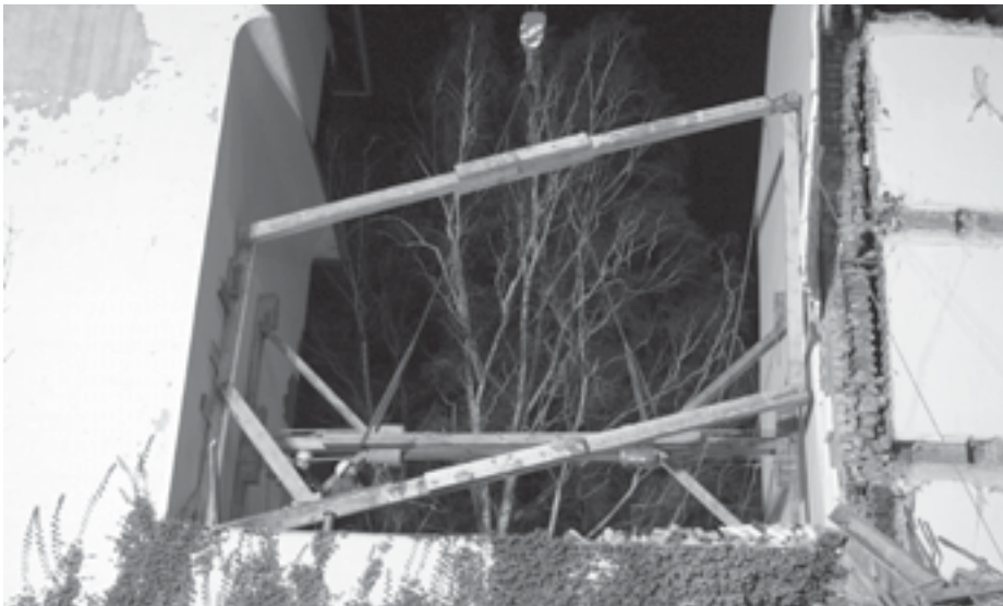
Das Sprengwerk aus dem ASH wurde mit Hilfe des Krans in Position gebracht. (Fotos: Stefan Wagner)
