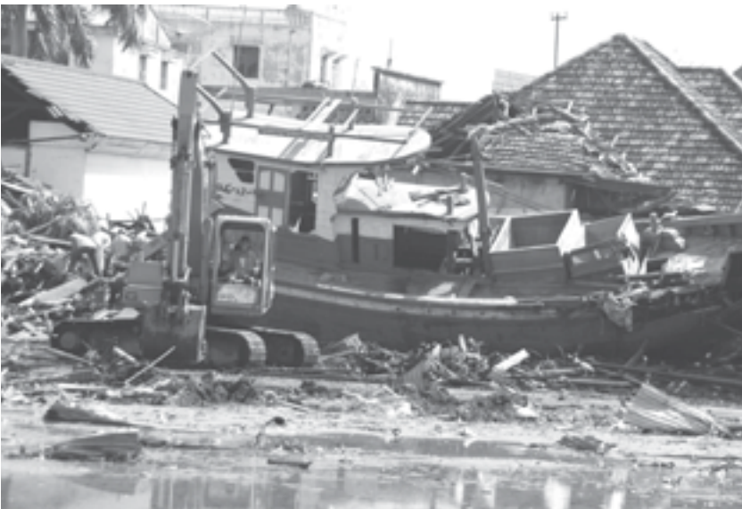
Vor dem Wiederaufbau sind umfangreiche Aufräumarbeiten erforderlich. (Fotos: THW)
