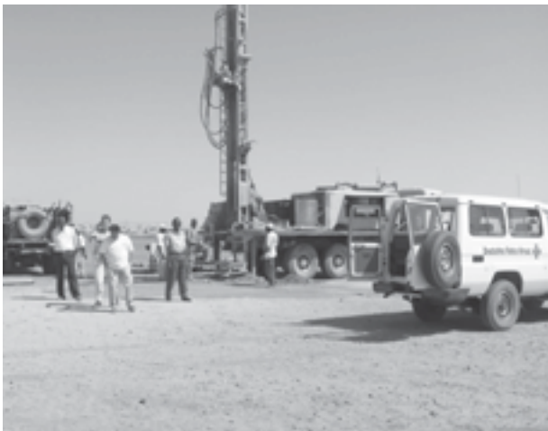
Der Bau neuer Brunnen gehört zur Grundsicherung. (Fotos. DRK)
