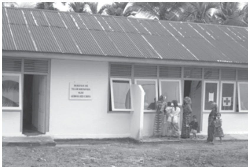
Die vom DRK reparierte Gesundheitsstation in Teunom/Indonesien. (Fotos: DRK)
