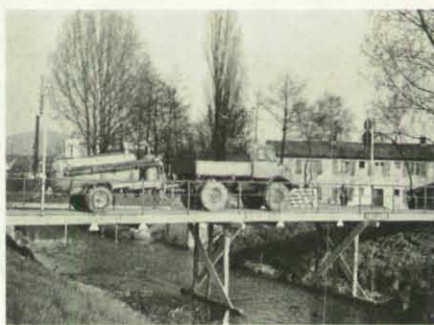
Die fertige 16-Tonnen-Brücke wird bereits genutzt.
