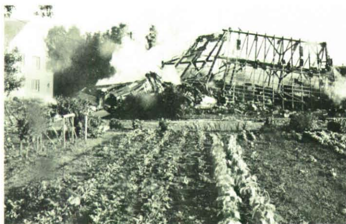
In einen Berg aus Schutt und Asche wurde dieses Zweifamilienhaus durch den Absturz eines Phantom-Jägers verwandelt. In der Bildmitte sind noch die Reste des Jägers zu erkennen.
