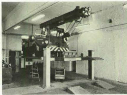
Wichtiges Arbeitsgerät in der neuen Zentralwerkstatt: die 20-t-Hebebühne.
