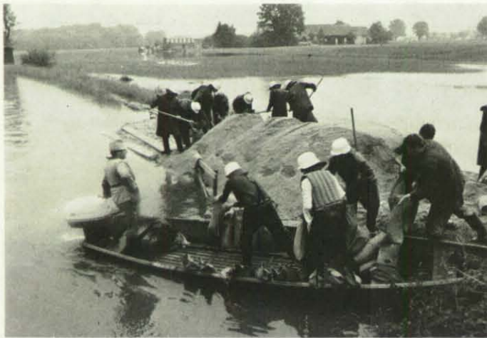
Dammbüche machten den Hilfsmannschaften immer wieder zu schaffen. Hier wird ein Damm der Amper bei Moosburg von der Feuerwehr mit Sand provisorisch geflickt.
