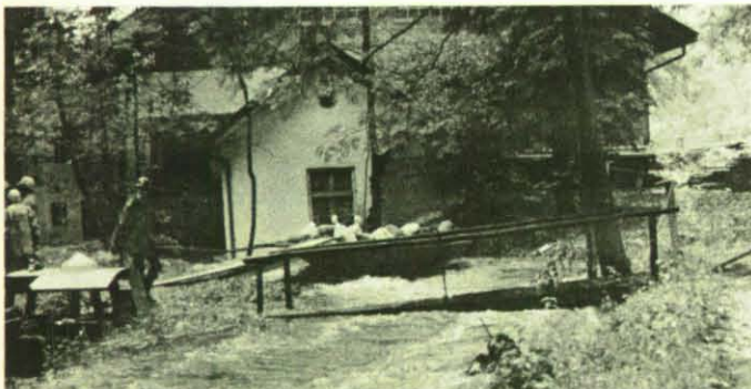
Keller und Maschinenhalle eines Sägewerkes waren überflutet – auch hier half das THW mit einem Pumpeinsatz.
