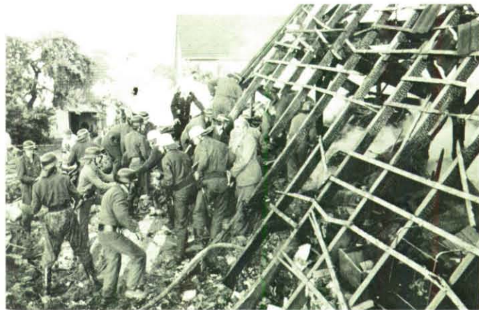
Durch den auslaufenden Treibstoff des Flugzeuges und die Detonation der Übungsmunition brannte das Haus wie eine Fackel. Die Feuerwehrmänner benötigten einige Stunden, um den Brand unter Kontrolle zu bekommen.
