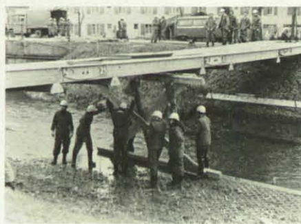
Das Leichtmetall-Brückenbaugerät wurde frei über den Oos-Kanal vorgeschoben.
