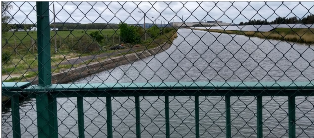
Abb. 8: Einlaufkanal mit verbauten Ufern (aus Richtung Spandowerhagen) Quelle: ÖKOPLAN 2020
