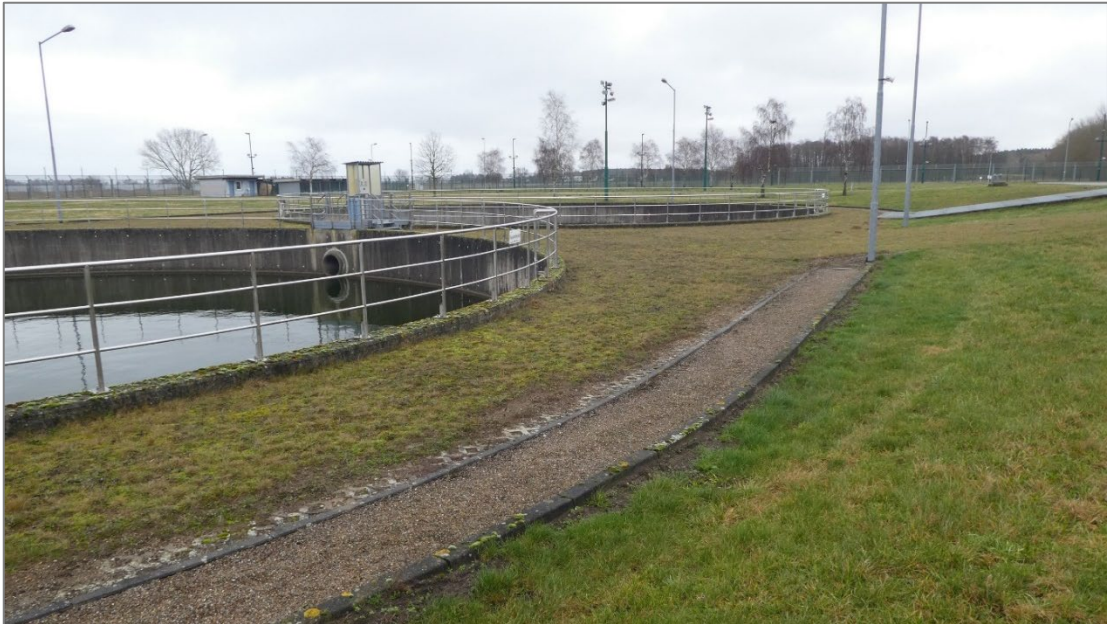
Abb. 7: Bauliche Strukturen im umzäunten Bereich (Blick über den umzäunten Bereich nach Osten) Quelle: EWN Entsorgungswerk für Nuklearanlagen GmbH
