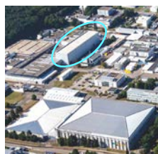
Neues LAW-Zwischenlager Zweck: Logistik-/Bereitstellungshalle
